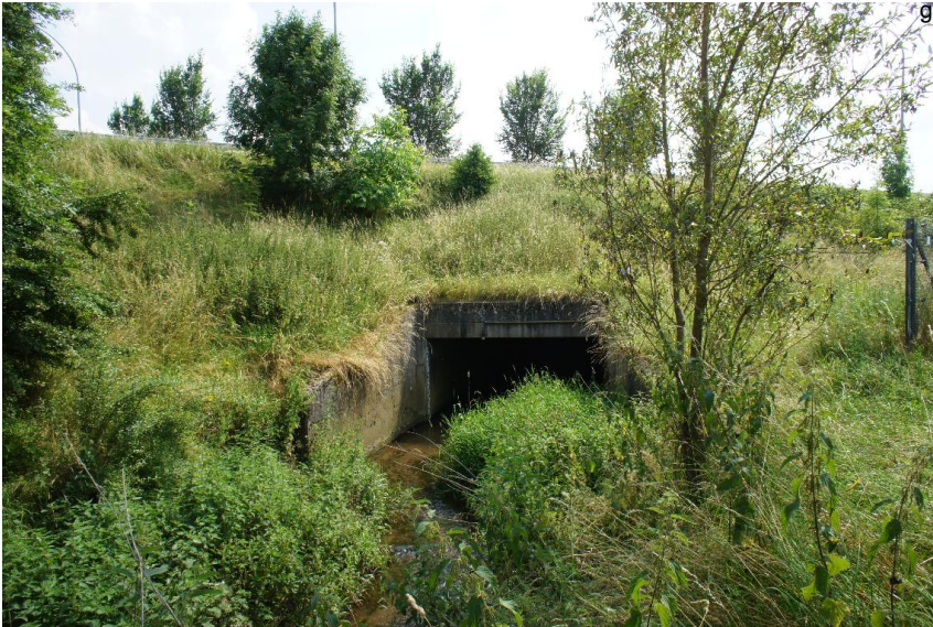
verrohrt bzw. ueberdeckt
