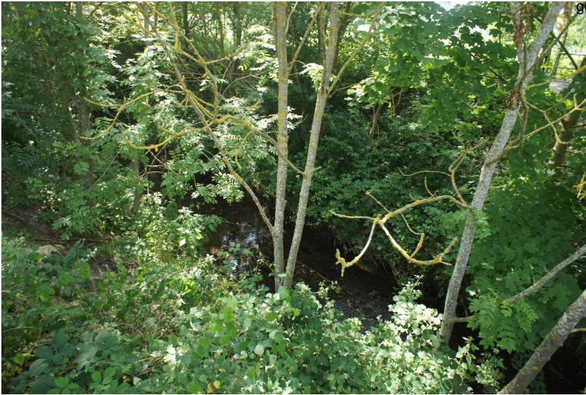
Sohlenverbau - Galerie; nicht bodenstaendig
