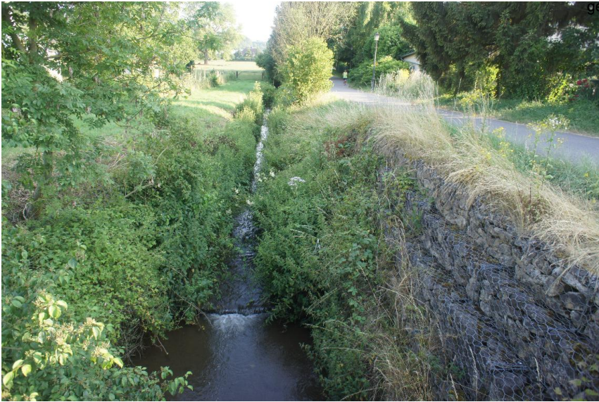
Absturz; kleiner - Uferverbau Steinsatz unverfugt
