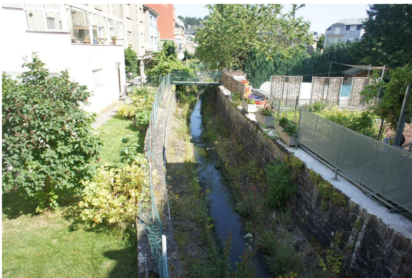
Kastenprofil - Absturz; kleiner - Durchlass; nicht strukturschädlich
