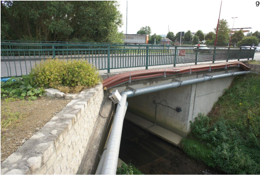
Durchlass; Ufer unterbrochen
