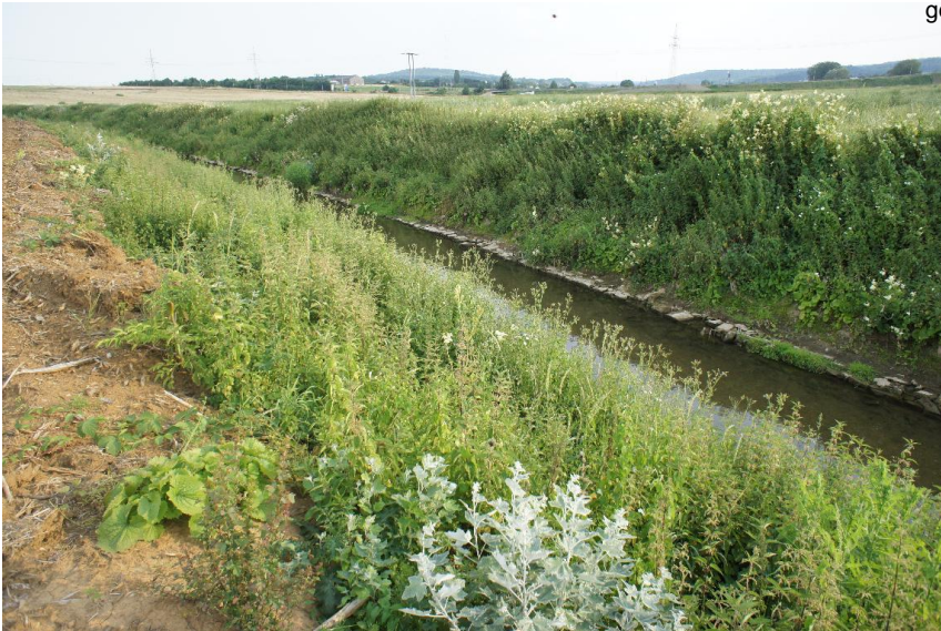
Brache - Uferbefestigung durch Steinblöcke
