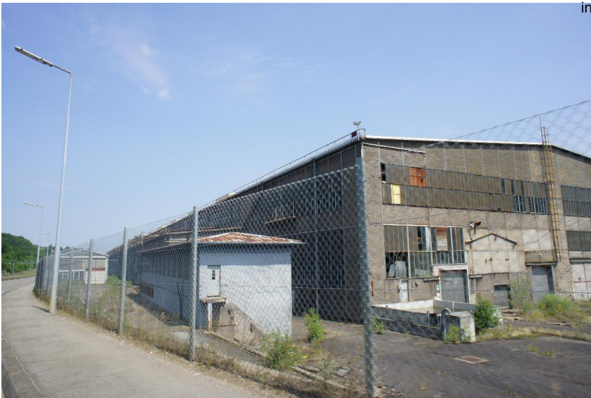
verrohrt bzw. ueberdeckt
