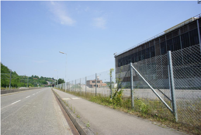
verrohrt bzw. ueberdeckt
