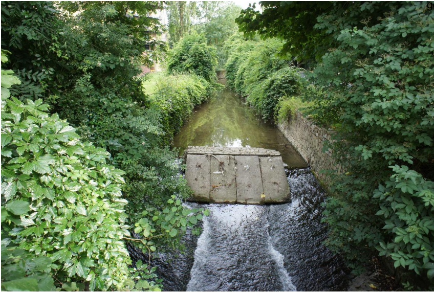
HWS Bauwerk - Wehr - Kastenprofil
