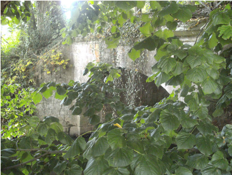
Durchlass; Ufer unterbrochen
