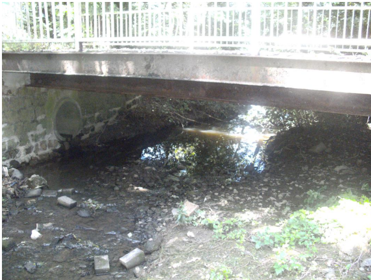
Durchlass; Ufer unterbrochen
