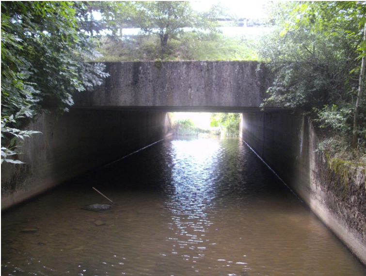
Durchlass; Ufer unterbrochen
