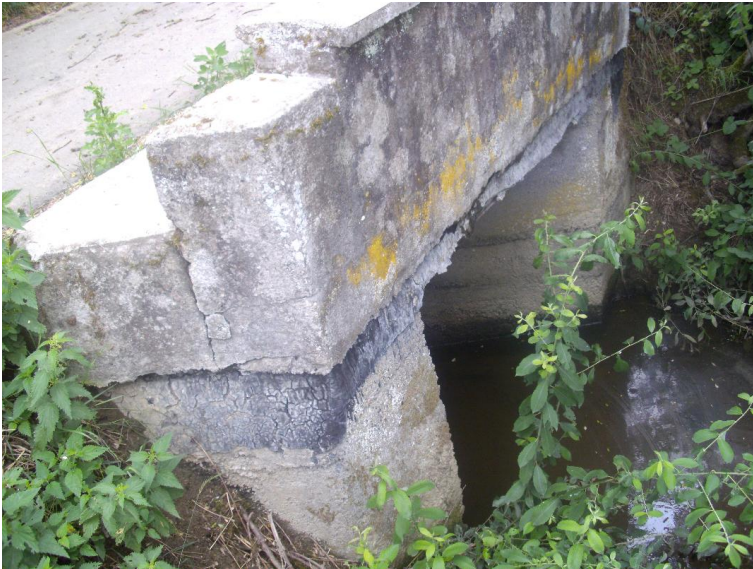
Durchlass; Ufer unterbrochen
