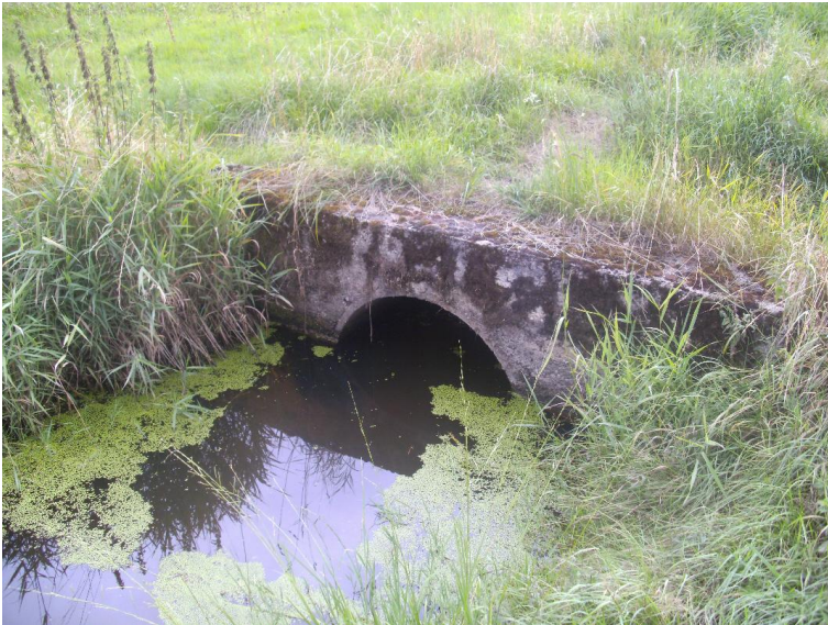
Durchlass; Ufer unterbrochen
