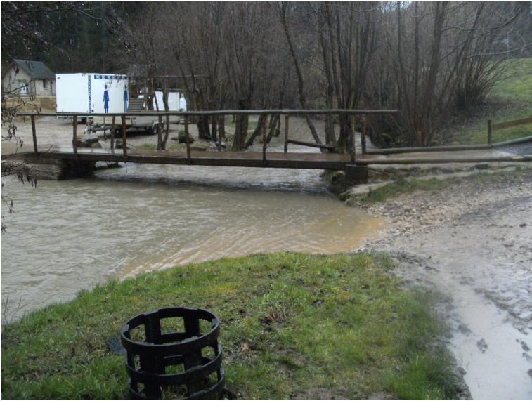
Durchlass; Ufer unterbrochen
