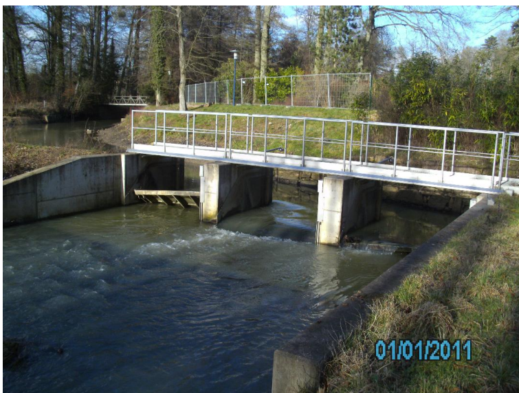
Durchlass; Ufer unterbrochen
