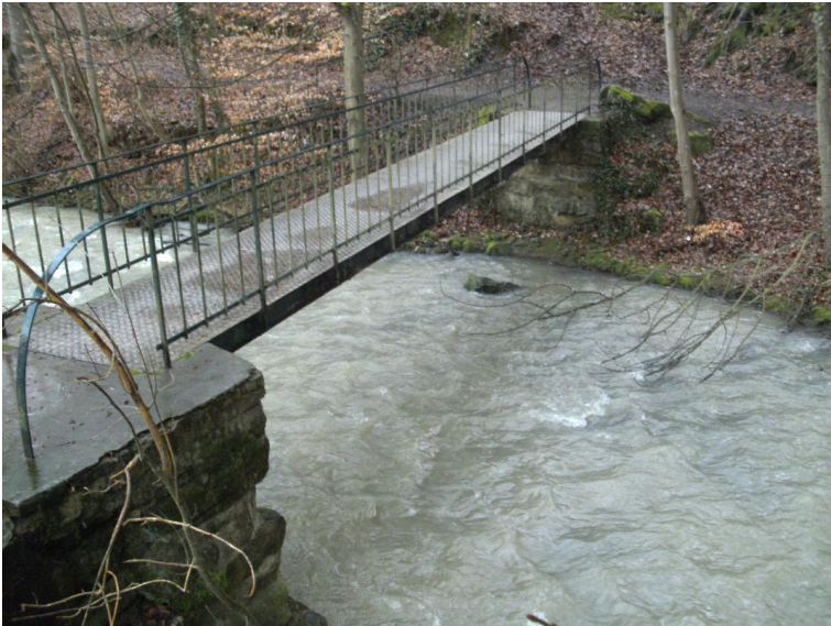
Durchlass; Ufer unterbrochen
