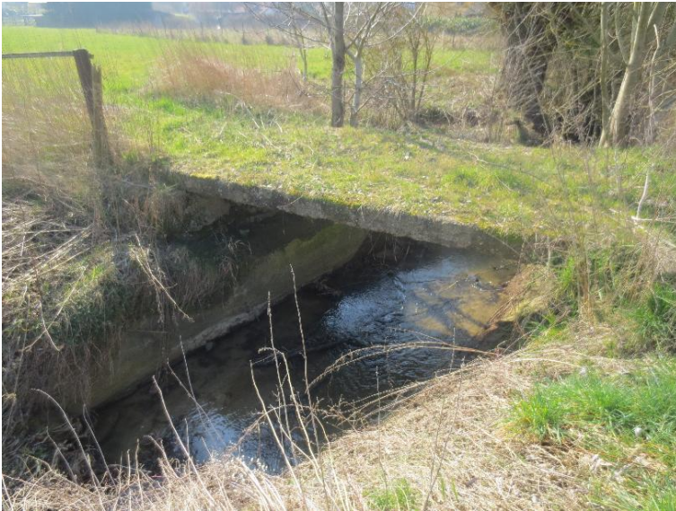
Durchlass; Ufer unterbrochen
