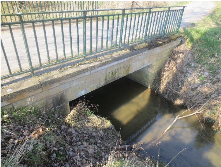
Durchlass; Ufer unterbrochen
