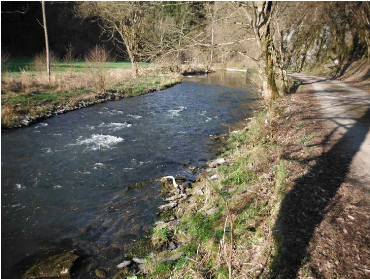
Uferverbau Steinsatz unverfugt
