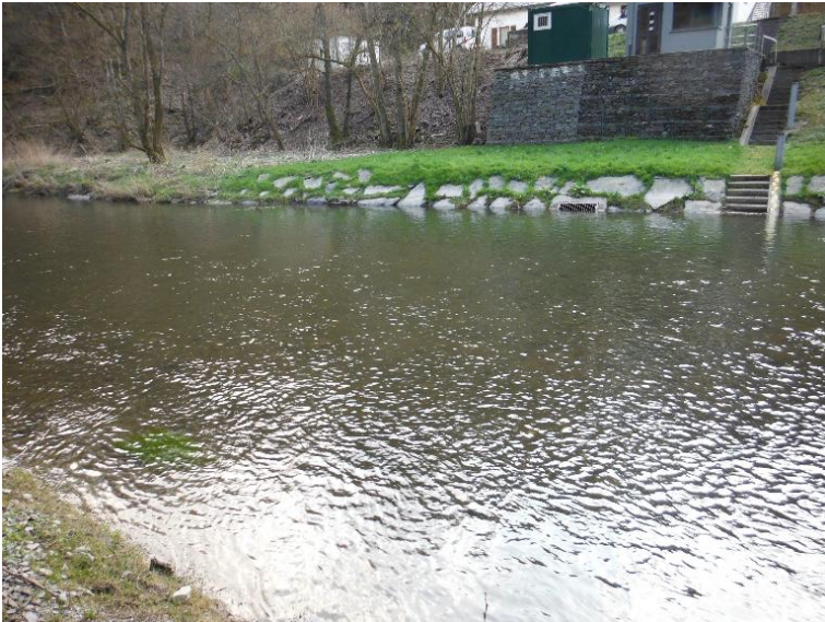
Uferverbau Steinsatz unverfugt
