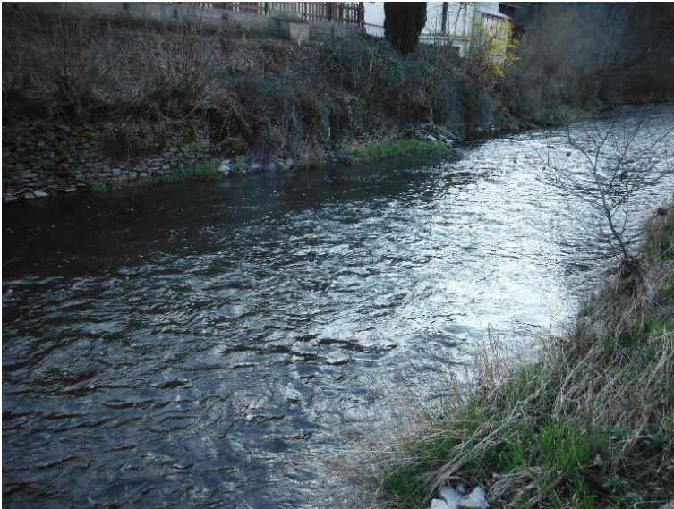
Uferverbau Steinsatz unverfugt
