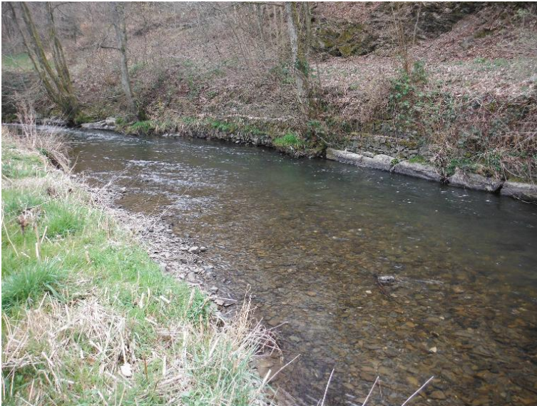
Uferverbau Steinsatz unverfugt
