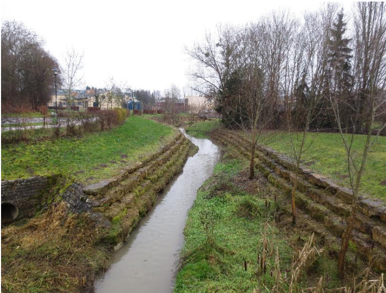
Uferverbau Steinsatz unverfugt
