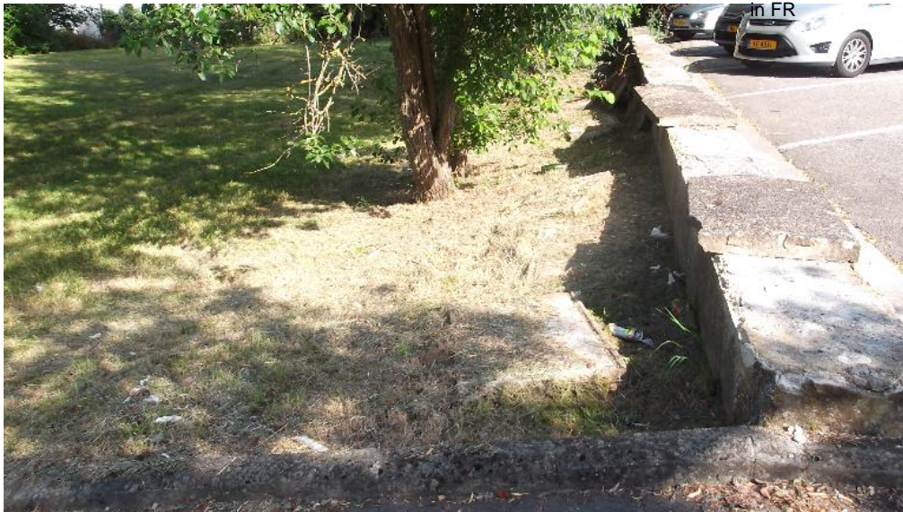
verrohrt bzw. ueberdeckt
