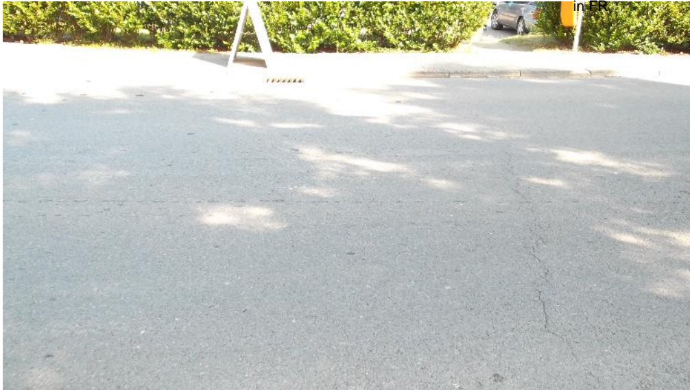
verrohrt bzw. ueberdeckt
