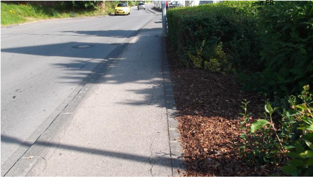
verrohrt bzw. ueberdeckt
