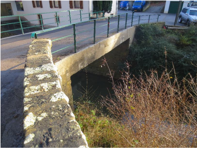
Durchlass; Ufer unterbrochen
