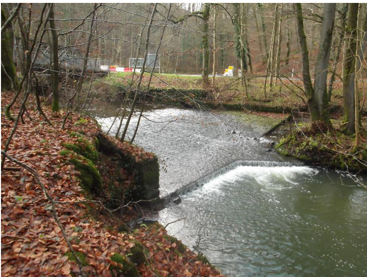
Raue Rampe mit Aufweitung
