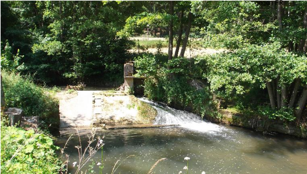
Raue Rampe mit Aufweitung
