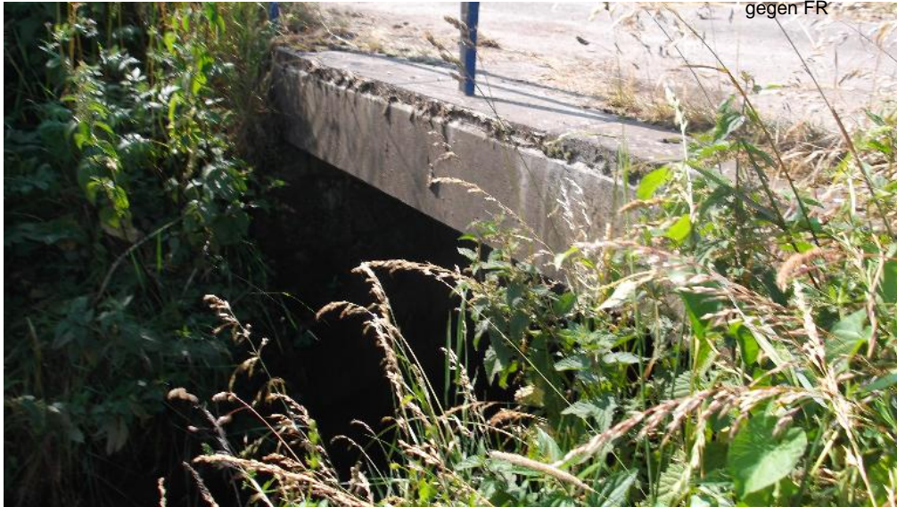
Bruicke siehe Durchlass - Bruicke siehe Durchlass
