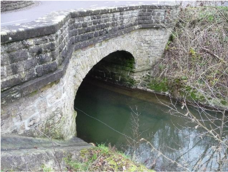
Durchlass; Ufer unterbrochen
