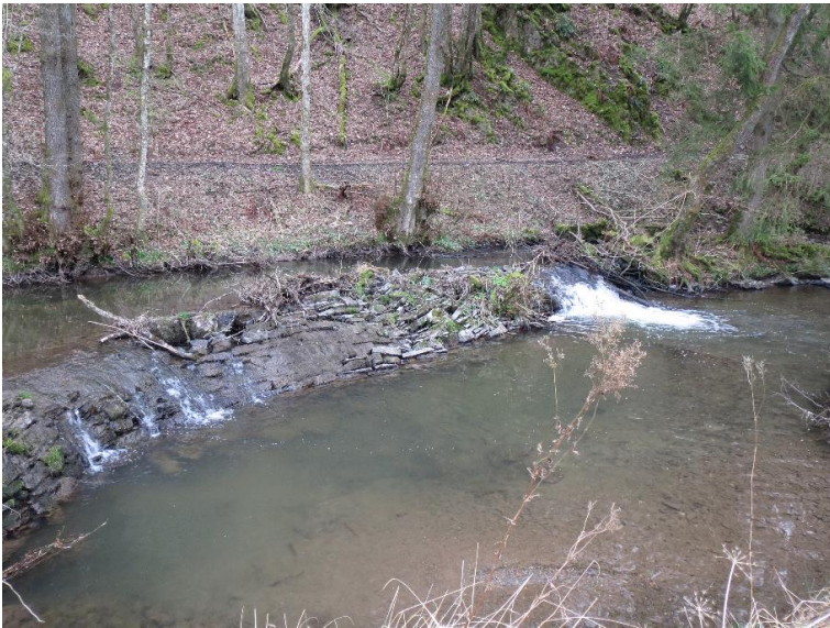
Raue Rampe - Raue Rampe mit Fischdurchlass
