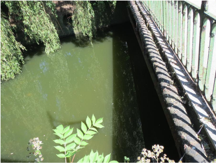
Durchlass; Ufer unterbrochen
