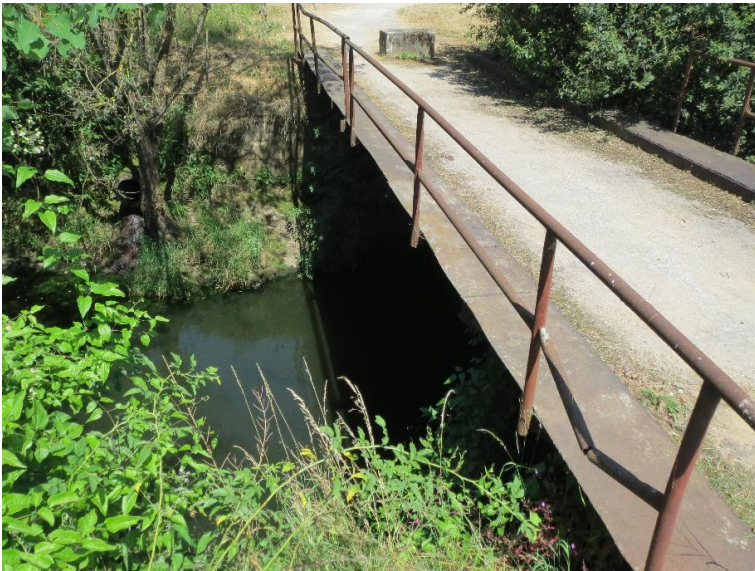
Durchlass; Ufer unterbrochen
