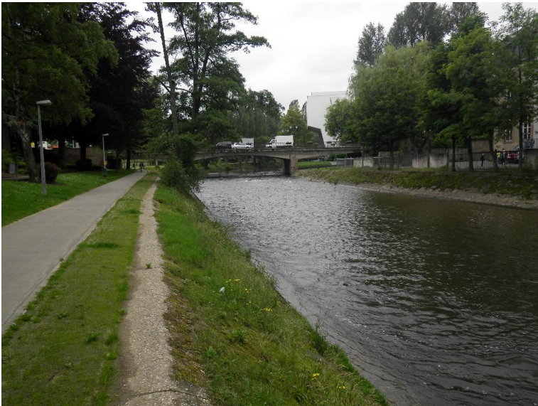
Durchlass; Ufer unterbrochen
