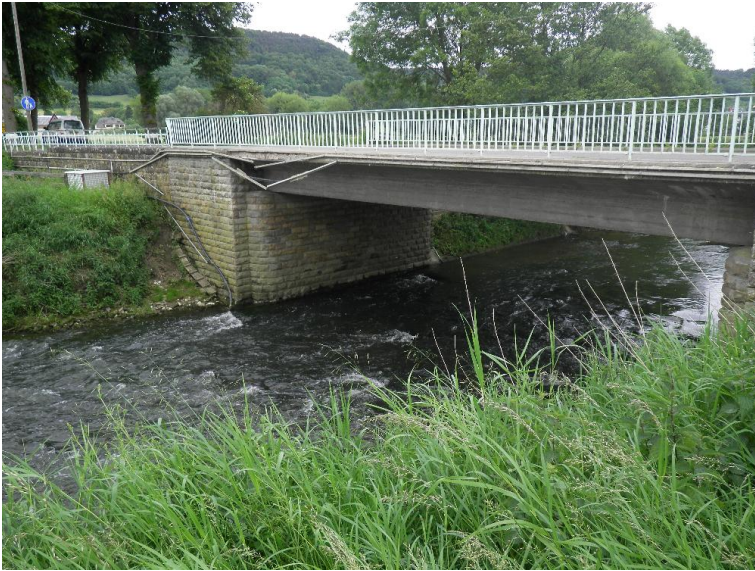
Durchlass; Ufer unterbrochen
