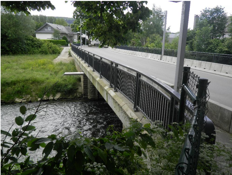
Durchlass; Ufer unterbrochen
