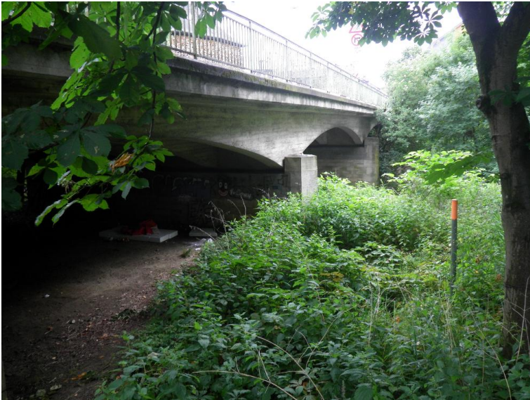
Durchlass; Ufer unterbrochen
