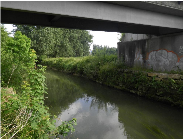
Durchlass; Ufer unterbrochen
