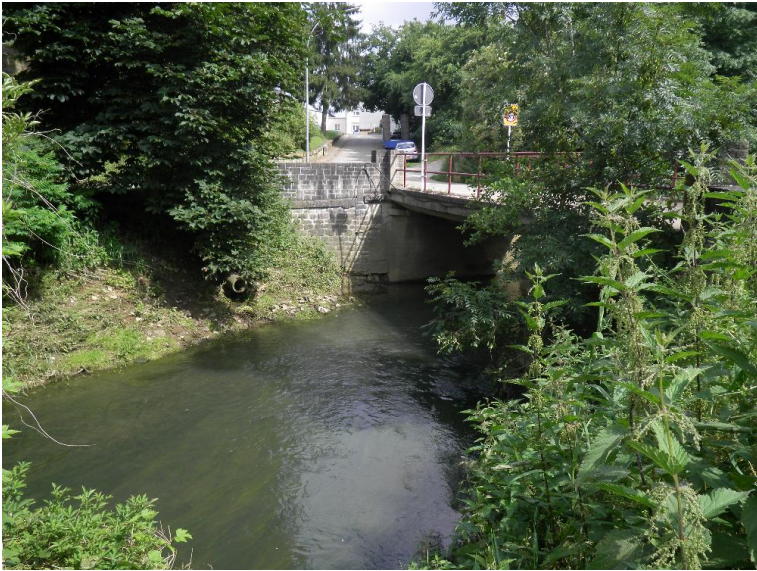
Durchlass; Ufer unterbrochen
