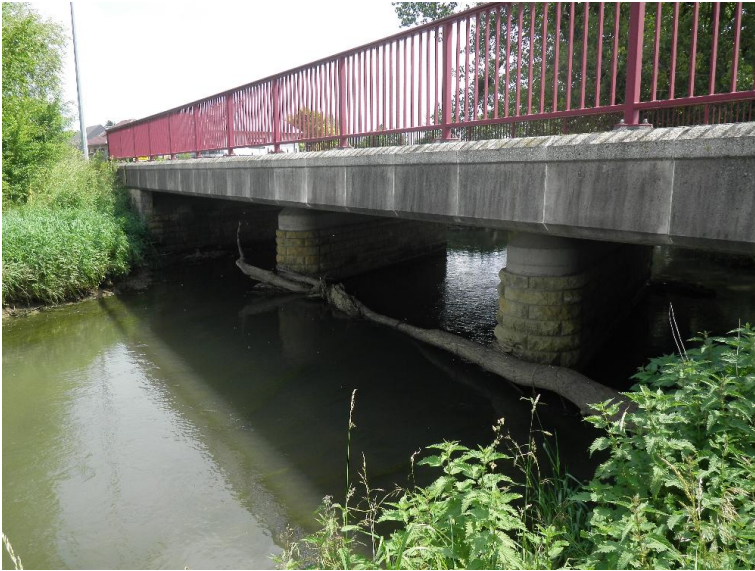
Durchlass; Ufer unterbrochen
