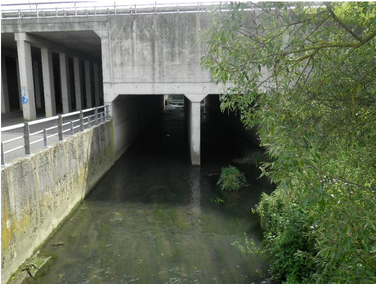
verrohrt bzw. ueberdeckt
