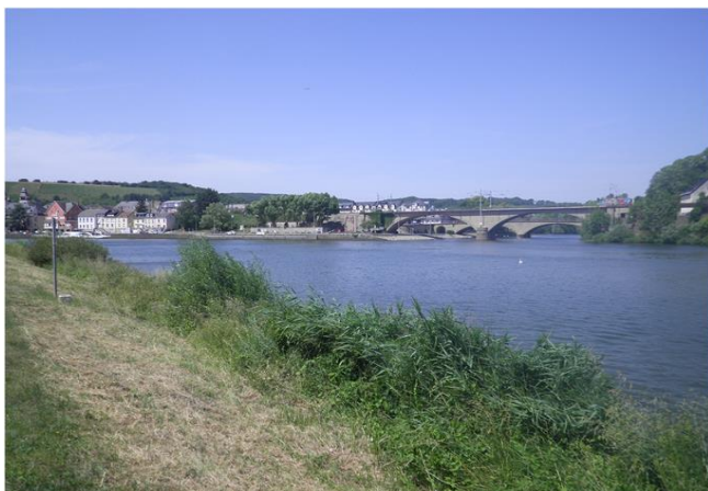
Foto gegen Fließrichtung
