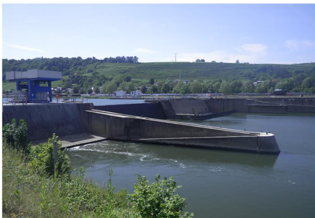
Foto gegen Fließrichtung
