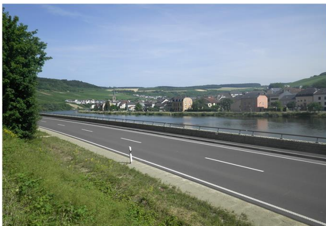
Foto gegen Fließrichtung
