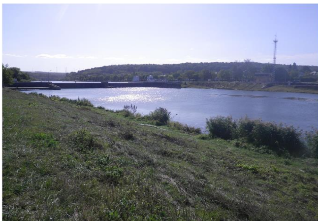
Foto gegen Fließrichtung
