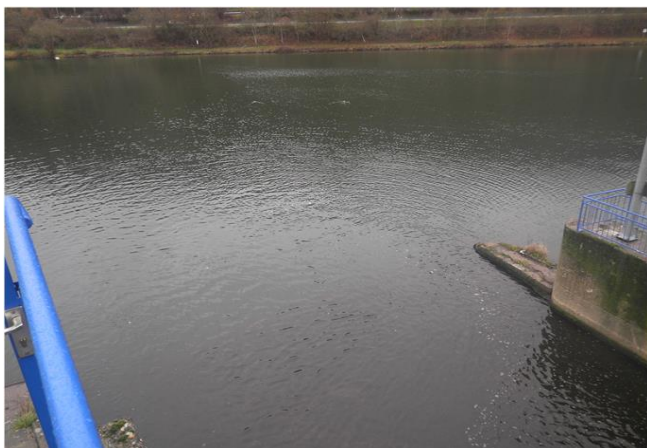
Foto gegen Fließrichtung
