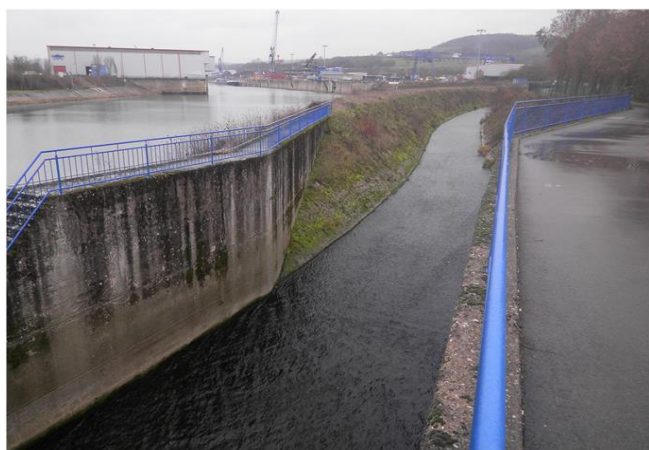
Foto gegen Fließrichtung
