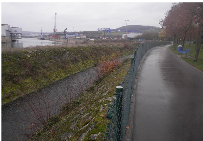
Foto gegen Fließrichtung
